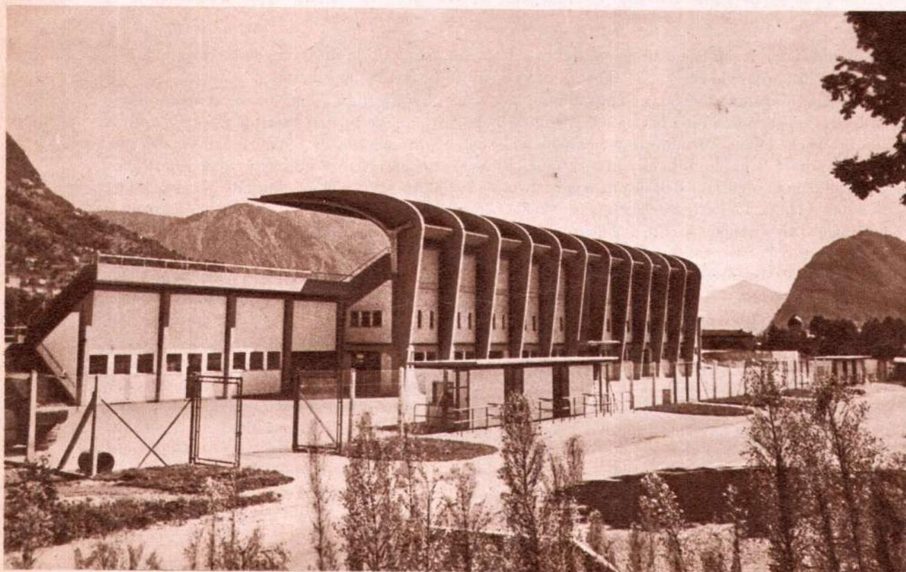
tali di cemento ad alta resistenza, gli elementi principali della costruzione in conglomerato cementizio armato essendo preventivamente vibrati.
