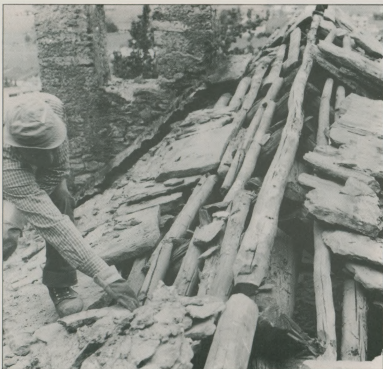
Si stanno togliendo le piode e appare la travatura
