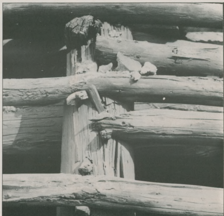
Particolare della travatura con chiodi in legno
