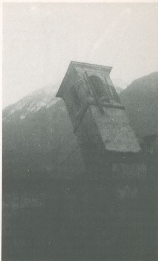
1956 - Demolizione dell'Oratorio San Rocco. L'istanza è stata scattata dal sig. Tilio Rivera.
