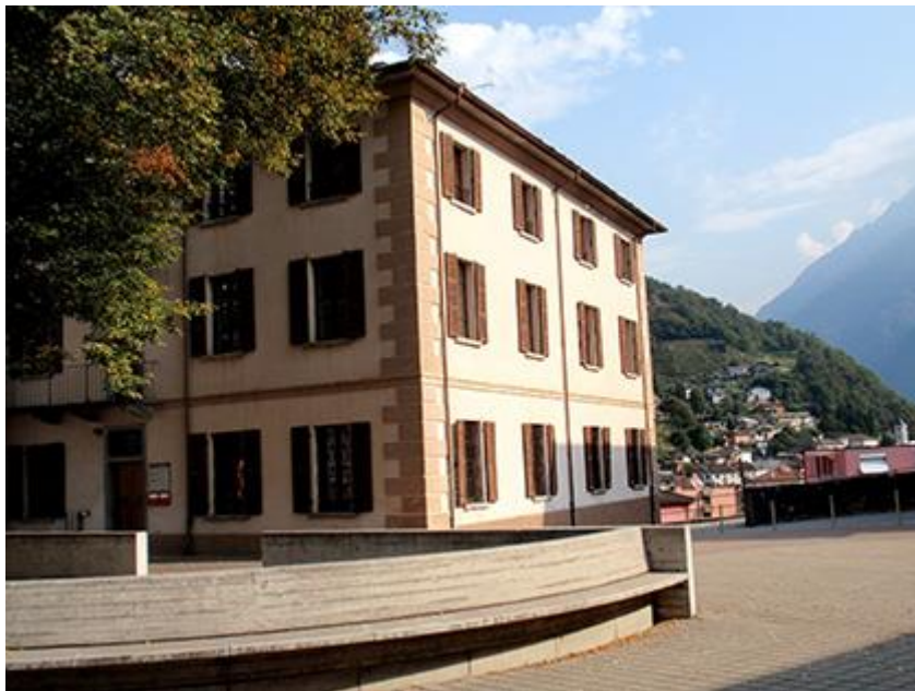
La scuola e casa comunale di Roveredo costruita nel 1856.
