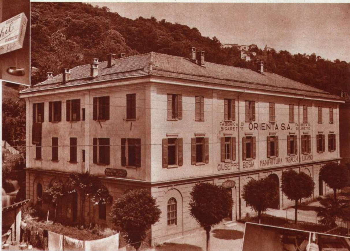
Veduta generale della Fabbrica.
