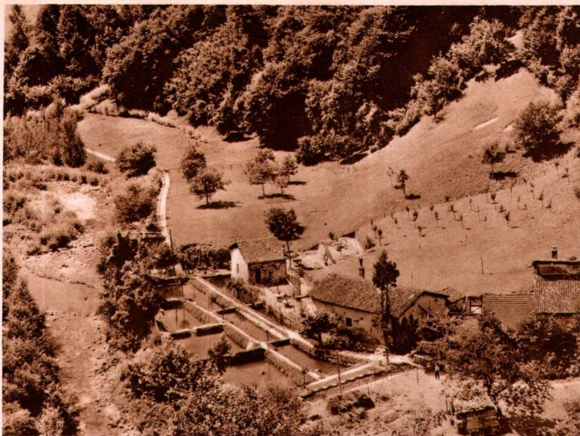
Fot. A - Troticoltura Contini & C., Magliaso. Veduta di 6 vasche e caseggiati annessi.
