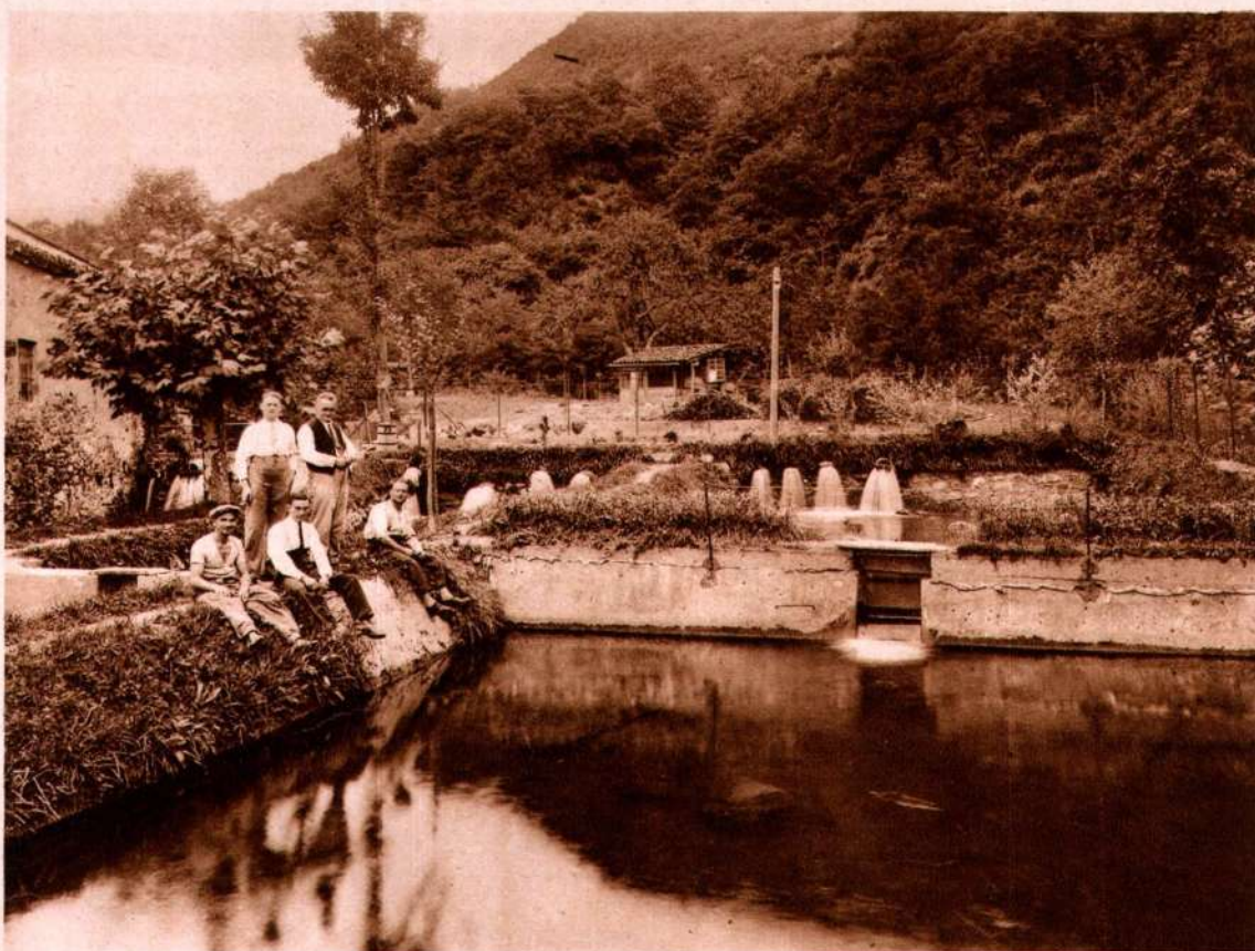
Fot. B - Troticoltura Contini & C., Magliaso. Dettaglio di una vasca della fotografia A. In questa fotografia si vedono 8 importanti getti d'acqua che alimentano le vasche.
