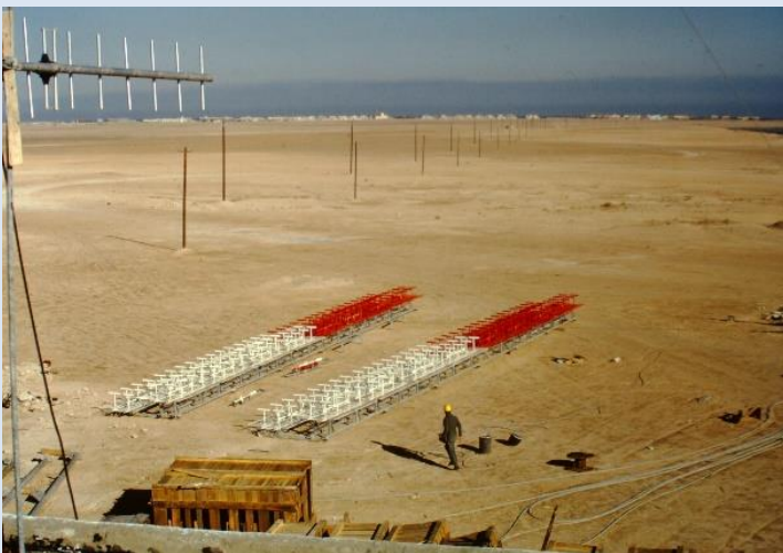
1971. Isola di Failaka, Kuwait, Golfo Persico. Pannelli dell' antenna TV montati e collaudati a terra, da issare sul traliccio di 300 m, in direzione e con perfetta visibilità sul territorio da servire. (Foto RR)
