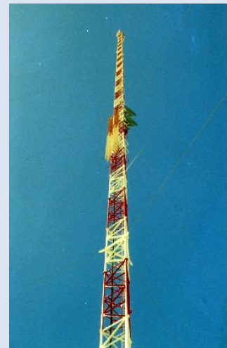
1971. Isola di Failaka, Kuwait, Golfo Persico. Pannelli dell' antenna TV montati e collaudati a terra, da issare sul traliccio di 300 m, in direzione e con perfetta visibilità sul territorio da servire. (Foto RR)
