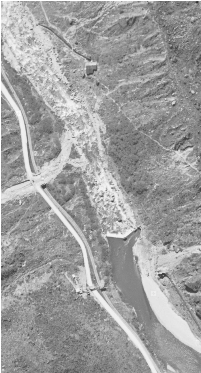
Foto aerea del 1934 della centrale e della diga (fonte: LUBIS - swisstopo).
